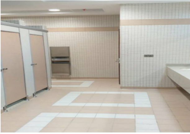
(مشروع اعمال تعديلات ببعض المكاتب بالمركز الإعلامي بفرع الزاهر)
