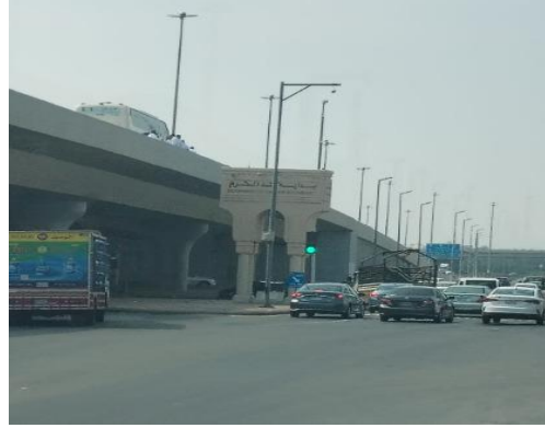
شكل ٧: موضع أعلام حدود الحرم (طريق السيل) وتأثير جسر المركبات عليه المصدر: تصوير الباحث (٢٠٢٤م)
