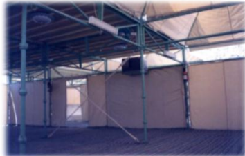
التهوية الطبيعية مهمة لصحة الحاج، ووحدات تكييف صغيرة لتلطيف الهواء في الصيف
