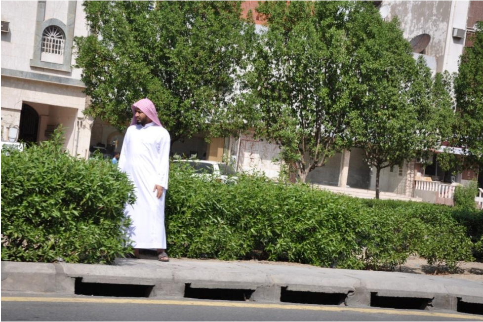
شكل رقم ١٨ : صورة فوتوغرافية توضّح الفتحات الجانبية للطريق لسحب مياه المطر في الطريق الدائري الثالث .
