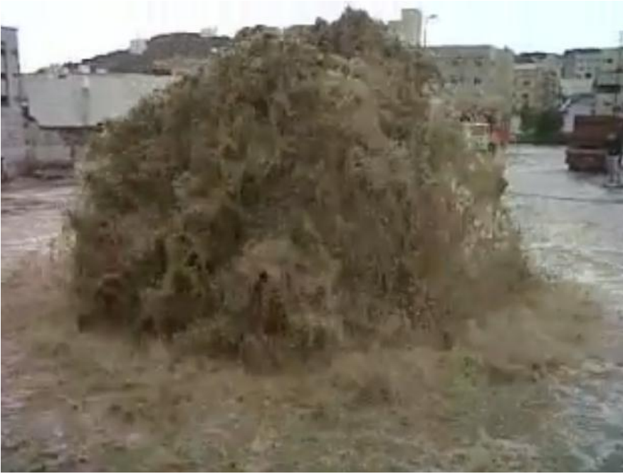
شكل رقم ٢١: صورة فوتوغرافية توضح انفجار أحد مصارف السيول تحت السطحية، يوم الخميس الموافق ٣٠ ديسمبر ٢٠١٠م (٢٤ محرم ١٤٣٢هـ)، نتيجة لعدم قدرتها على استيعاب مياه السيول.
