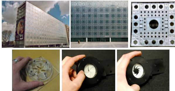
شكل ٢٥: يوضح ديناميكية الحركه في مبني المعهد العربي بباريس و الذي يتحكم من
