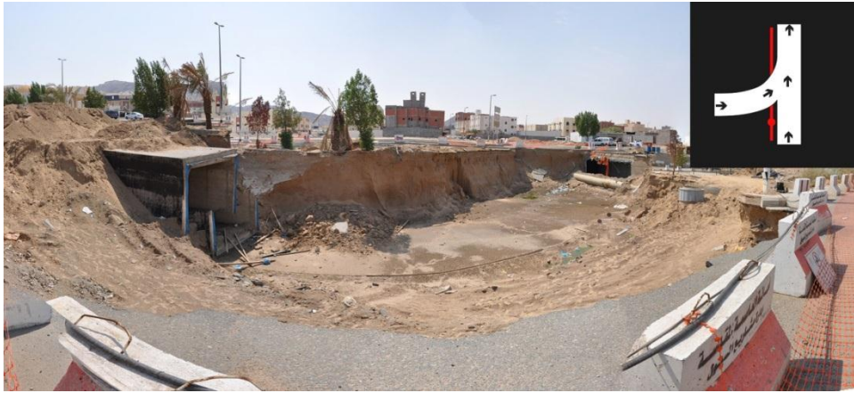
شكل رقم ١٢: بانوراما فوتوغرافية لأحد مخزّات السيول تحت السطحية (تحت الإنشاء) في حي بطحاء قريش بمكة المكرمة. الشكل في الركن العلوي الأيمن من الصورة هو عبارة عن رسم توضيحي لمنظر علوي لمحتوى الصورة الفوتوغرافية (الخط الأحمر هو ماسورة الصرف الصحي).
