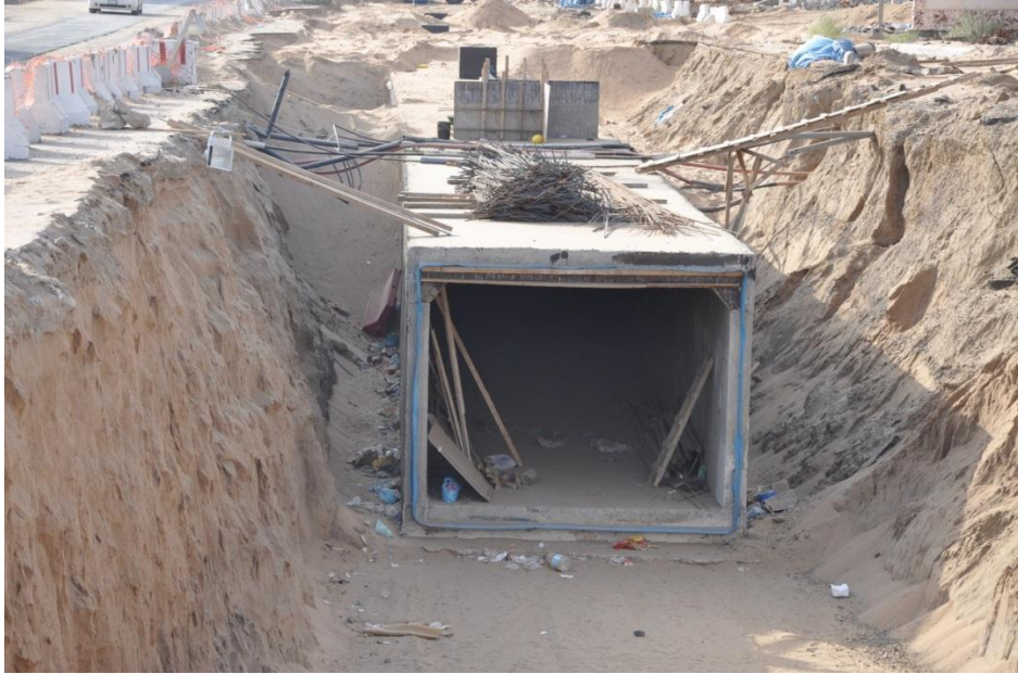
شكل رقم ١٣: صورة فوتوغرافية توضح أبعاد قناة تصريف السيول تحت السطحية.
