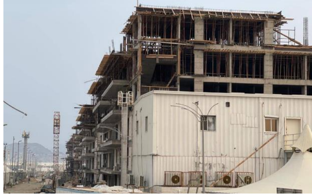
شكل 1 جانب من الأعمال الإنشائية أثناء تنفيذ المشروع. (المصدر: صحيفة مكة)
